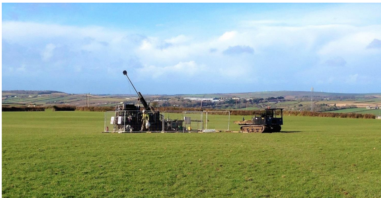
Figur 2 Borrregat, borrhållsregat och avspärrning.
